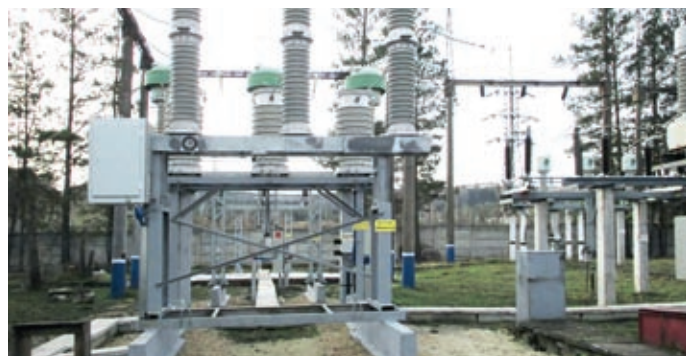
ПС 110/35/10 кВ «Ночка» после капитального ремонта
