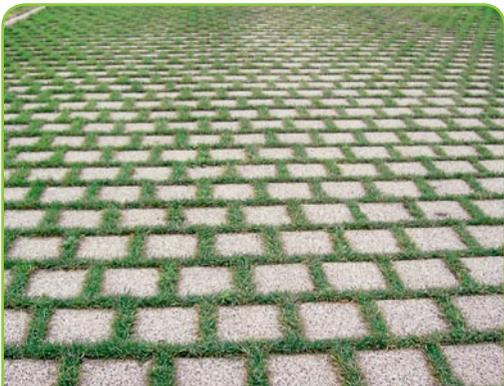
**Проницаемое покрытие парковки** позволяет воде впитываться в грунт, а также является симпатичным элементом окружения офиса.
