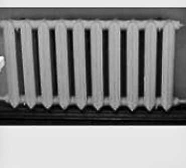
Тепловизионное обследование элемента системы отопления
