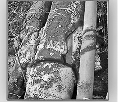
Тепловизионное обследование элемента системы теплоснабжения
