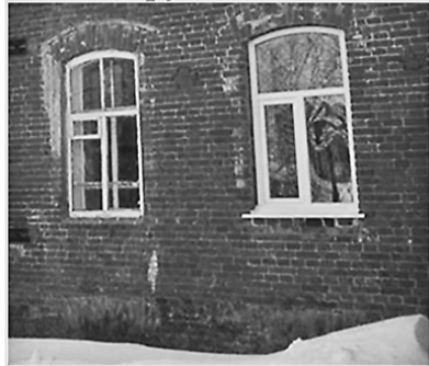
Тепловизионное обследование ограждающих конструкций здания
